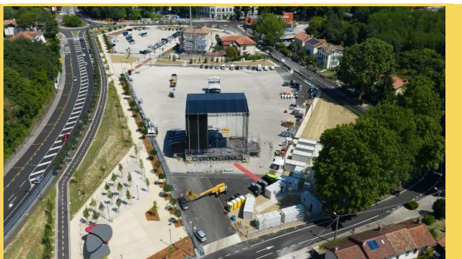
Parcheggio della Casa Rossa
